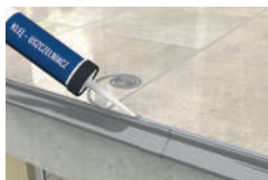
uszczelnienie dylatacji między profilami okapowymi a płytką
