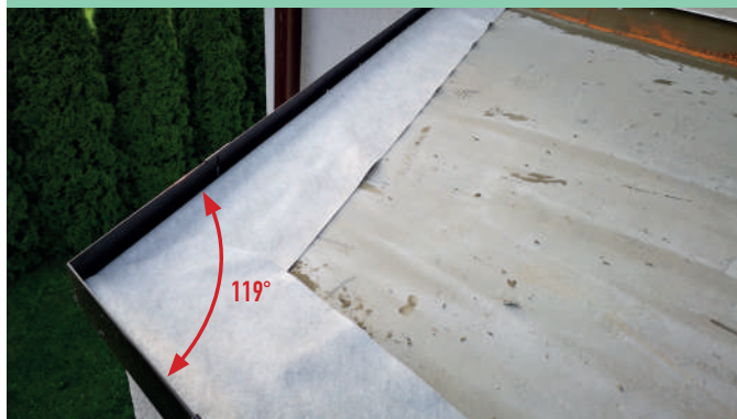
NAROŻNIK KĄT 119° - PROFIL W35 PLUS W TRAKCIE MONTAŻU
