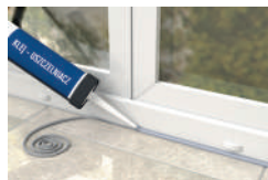
uszczelnienie dylatacji między posadzką a drzwiami
