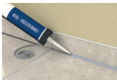
uszczelnienie dylatacji między posadzką a cokolikami
